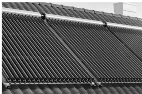
Solarthermie - Röhrenkollektor
